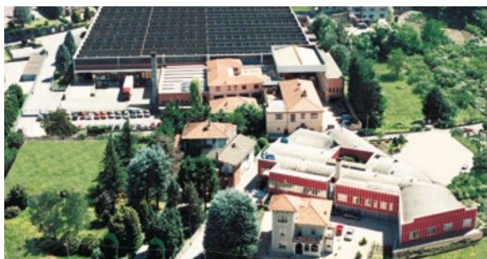
Stabilimento di San Maurizio d'Opaglio San Maurizio d'Opaglio manufacturing facility
