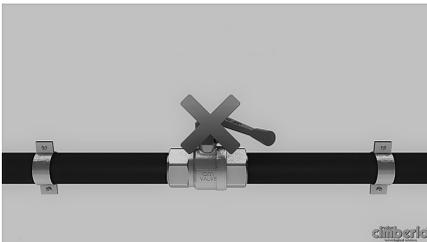
Non utilizzare le valvole come organo di regolazione, ma solo di intercettazione per evitare il danneggiamento dei sedgi.
